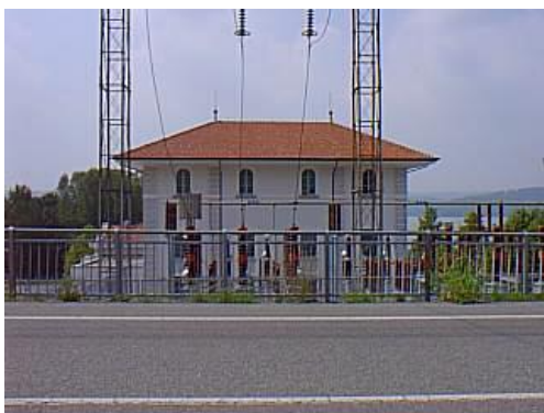
Foto.41: Ex Centrale elettrica
